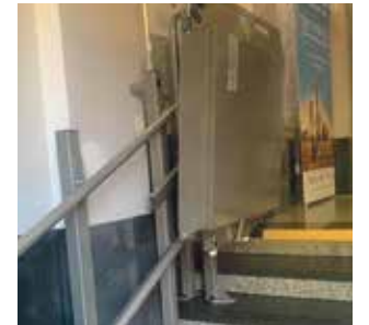
W Urzędzie Miejskim, w miarę możliwości, likwidowane są bariery architektoniczne. Zakupiono m.in. platformę przyschodową
