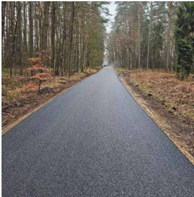
Nowa nakładka bitumiczna w Smolanej Budzie
