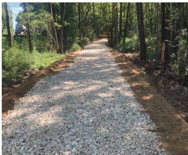
Trwa budowa szlaku rowerowego Woźniki – Dyrdy. Do czasu zakończenia prac na tym terenie obowiązuje zakaz wstępu
