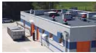
Rozbudowa oczyszczalni ścieków w Psarach
