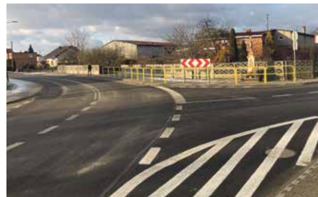
Przebudowa drogi powiatowej na odcinku Woźniki-Lubsza
